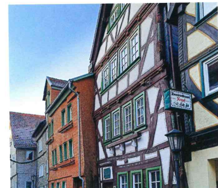
In den Fachwerkhäusern haben eine Wärmepumpe plus eXm und ein Pelletkessel die Erdgasheizung abgelöst. Statt rund 7.000 Euro pro Jahr zahlen die Diebels heute etwa 4.200 Euro für Energie.
